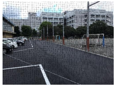
アスファルト舗装され広くなった駐車場
